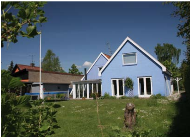
Huset efter renovering, set fra haven mod nord- nordvest, 22. maj 2008
