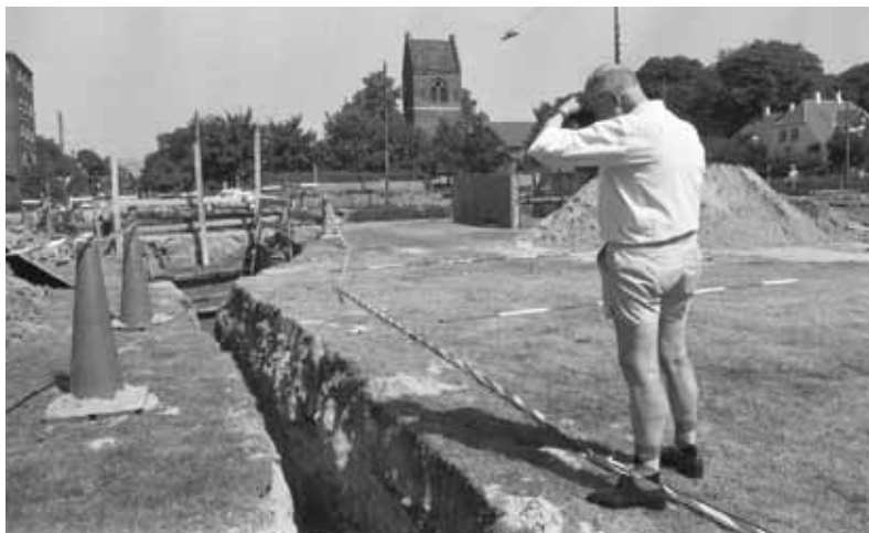
Nedlægning af naturgasrør gav Knud Hansen en enestående lejlighed til at studere fundamentet til det gamle bryggeri, hvor han var født. Som søn af brygger Axel Hansen havde han selvfølgelig ganske særlige følelser for stedet, 10. august 1983
