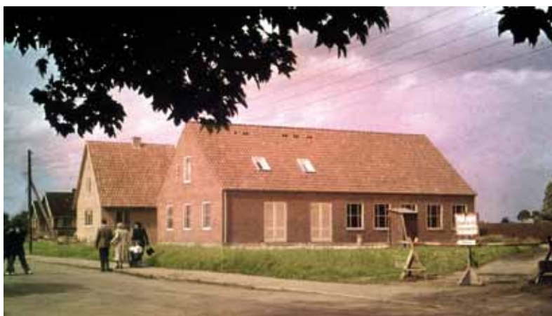
Solvangen Børnehaves hus på Nørre Allé 34 under opførelse, 6. juni 1949
